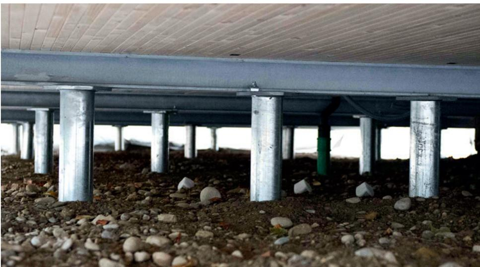
◄ Darstellung eines Gebäudeanschlusses: KRINNER-Schraubfundament an einer Unterkonstruktion des Gebäudes mittels Klemmsystemen.
