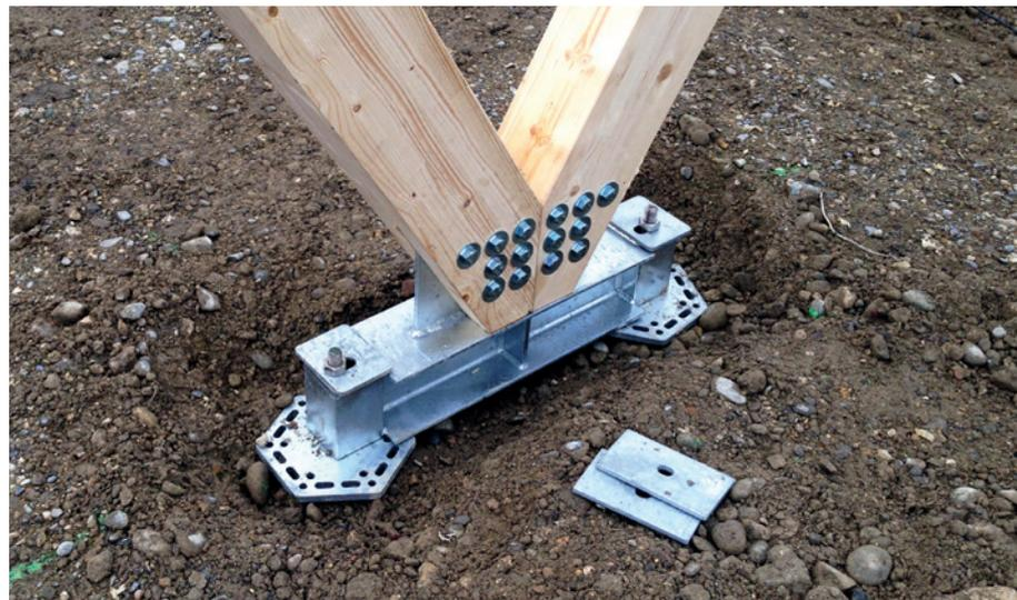
► Darstellung einer Gruppenfundamentierung mittels Stahlträger zur Lastverteilung bzw. höheren Einzellastaufnahmen.
