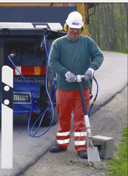
Pfosten setzen
