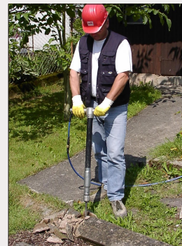
Aufspitzen von Beton
