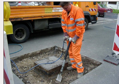
Lösen von Mineralbeton
