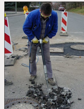
Aufbrechen von Asphalt
