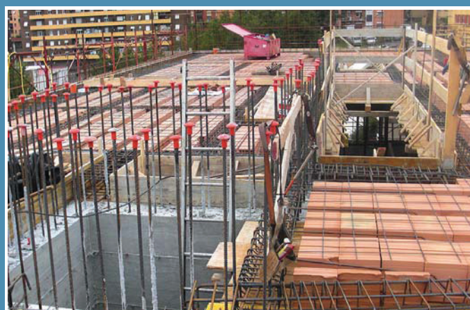
● Lavori in corso d'opera
