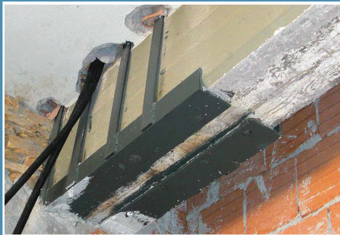
● Rinforzi sui pilastri esistenti
