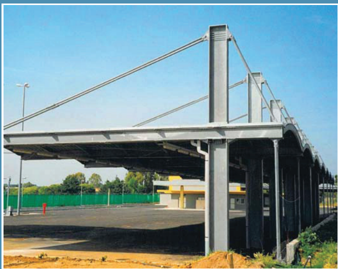
● Copertura strallata in carpenteria metallica
