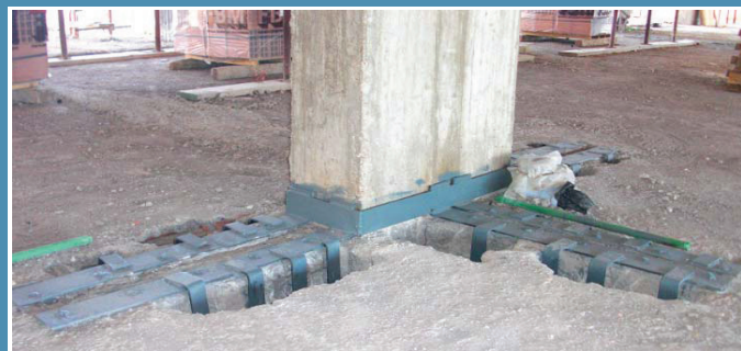
● Rinforzi sui pilastri esistenti
