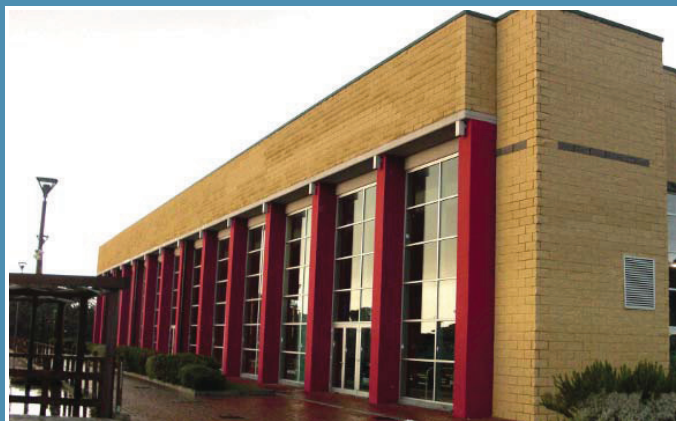
● Struttura piscina interna
