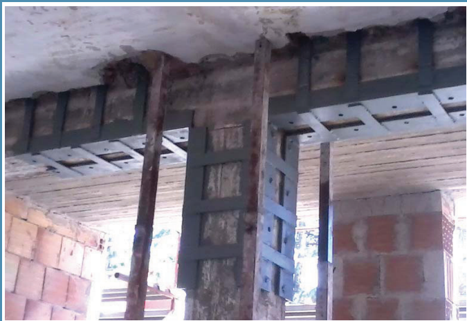
● Rinforzi sui pilastri esistenti
