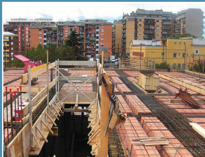
● Lavori in corso d'opera
