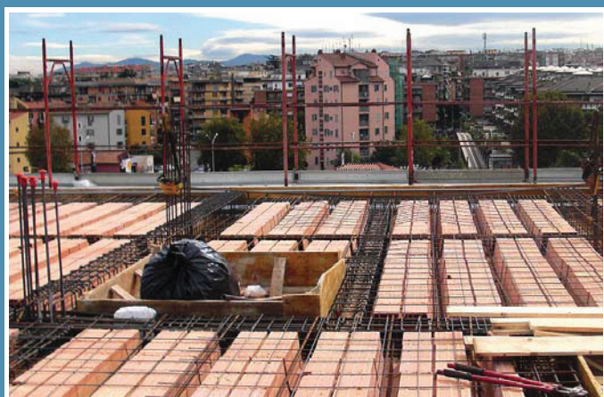
● Lavori in corso d'opera
