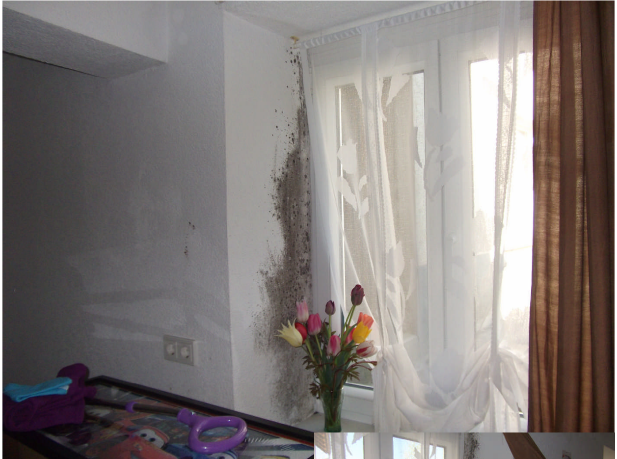
Wie vor: Schimmelbefall an der Fensterlaibung in der Küche.
