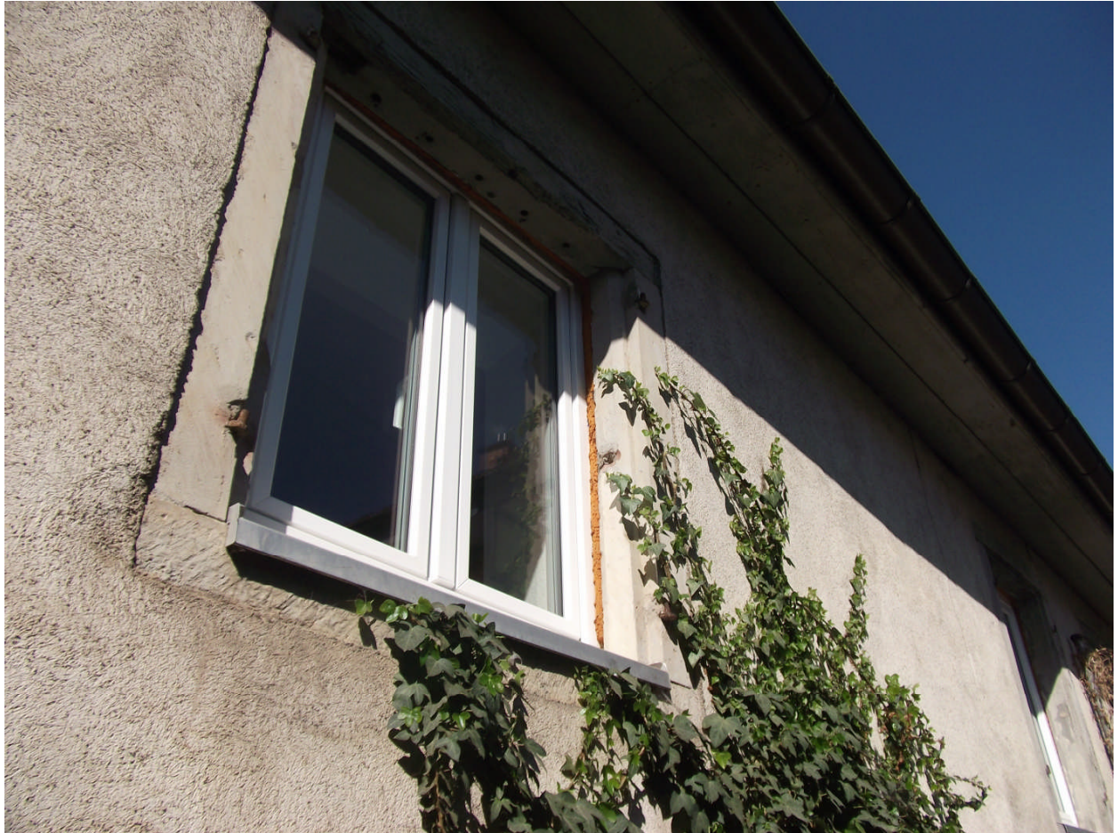
Rissbildung zwischen Holzlaibung und Wand
