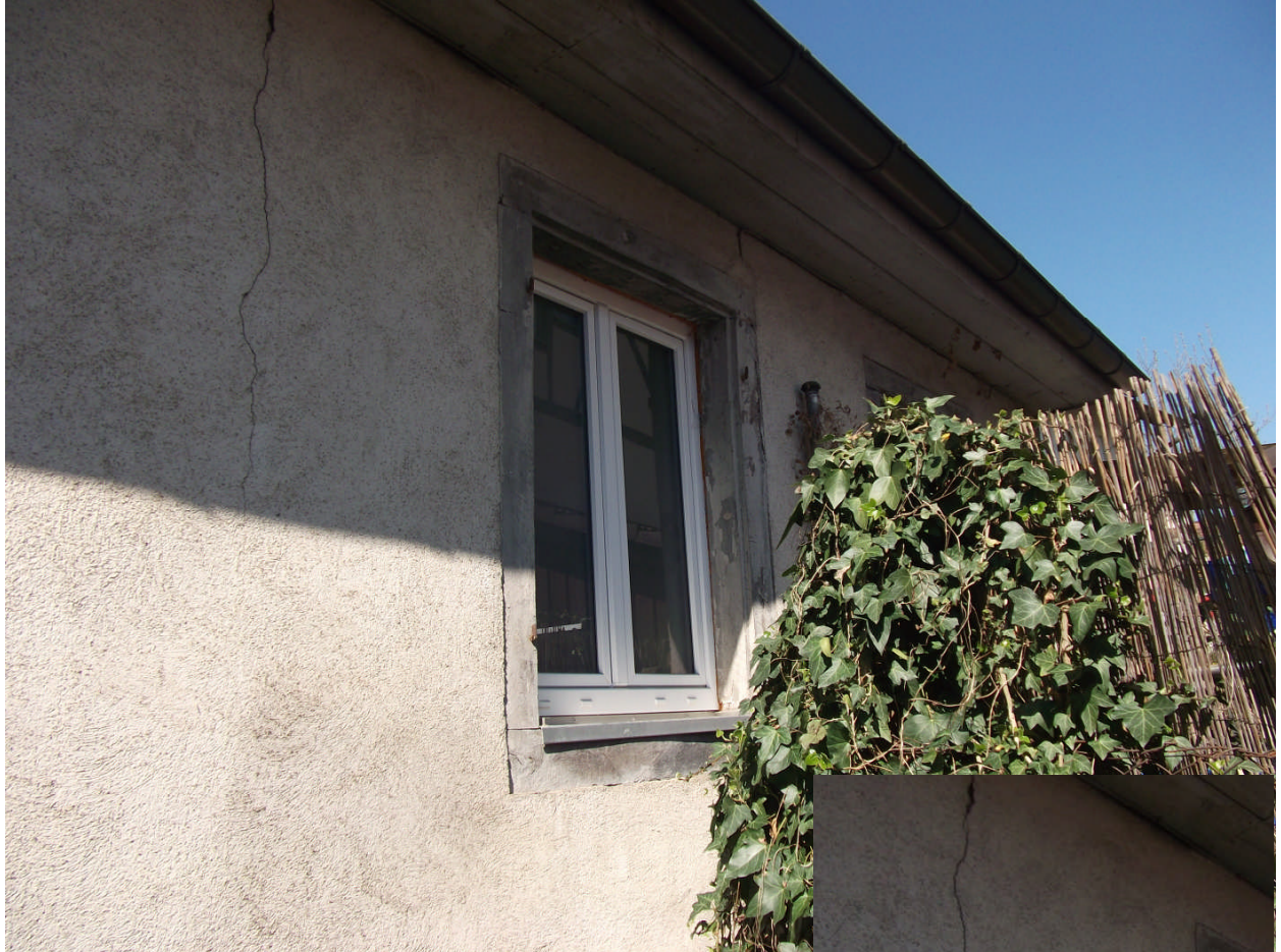
Riss in der Fassade – Breite ca. 4 mm im Mittel
