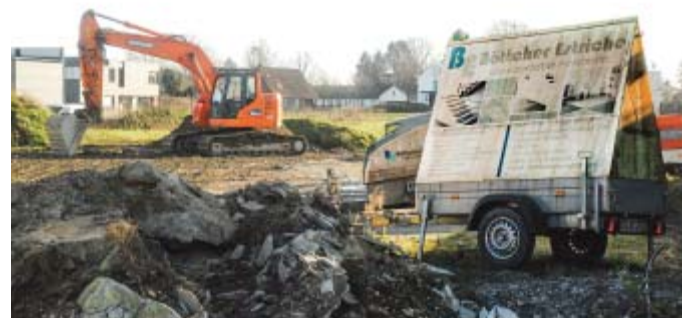
Neubau: Das Unternehmen Böttcher Estriche hat am Donnerstag mit den Arbeiten am Lerchenweg begonnen. Das meldete die Firma auch auf ihrer Facebook-Seite. FOTO: NATALIE GOTTLWALD
