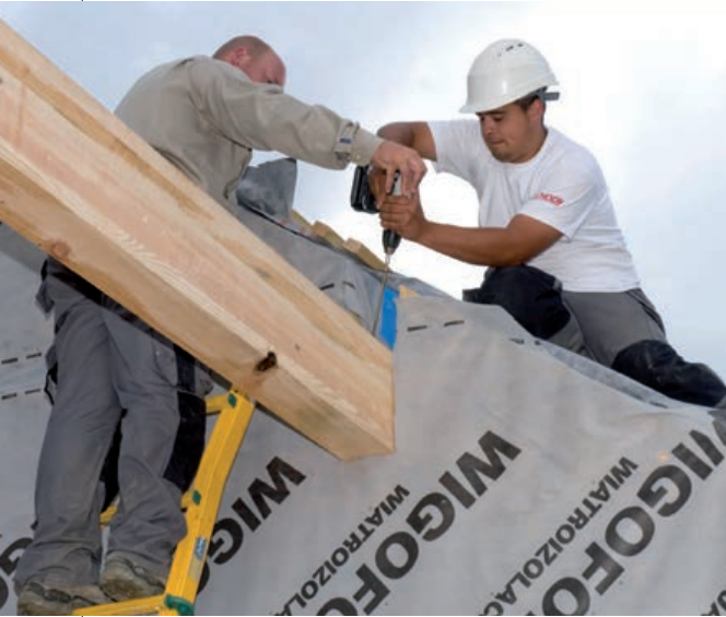
Pose des panneaux de toiture autoportants sur les poutres
