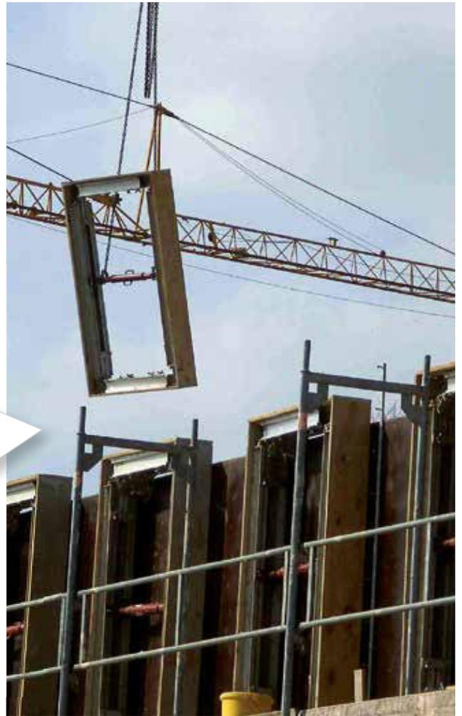
Schnelles Positionieren an der Wandschalung und einfaches Ausschalen durch Lösen weniger Schrauben
