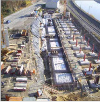
Zemseal® beim Einbau im Untergeschoss
