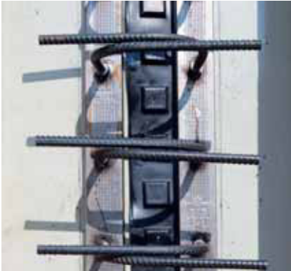
Vorkonfektionierte Coupler Bewehrungselemente im 1. BA mit zusätzlicher Verzahnung durch Fugenformprofil
