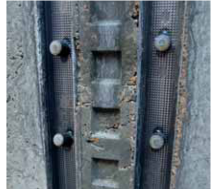
Betonierergebnis: Lage der Coupler-Muffen in der Verzahnungsfuge
