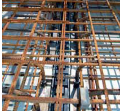
Bewehrungslage im 1. BA: Befestigung der WCA-Muffenstäbe mit der örtlichen Bewehrung
