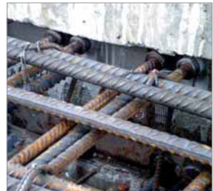
Exakte Bewehrungslage im 2. Betonierabschnitt durch einfache Montage der Coupler Anschlussstäbe in der Verzahnungsfuge.
