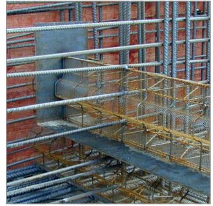
**Stremaform® mit Fugenblech Bodenplatte/Decke**
