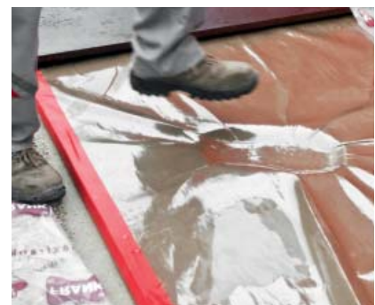
nach 24 Stunden ist die Tragfähigkeit der Egcovoid Setzungsplatte zerstört
