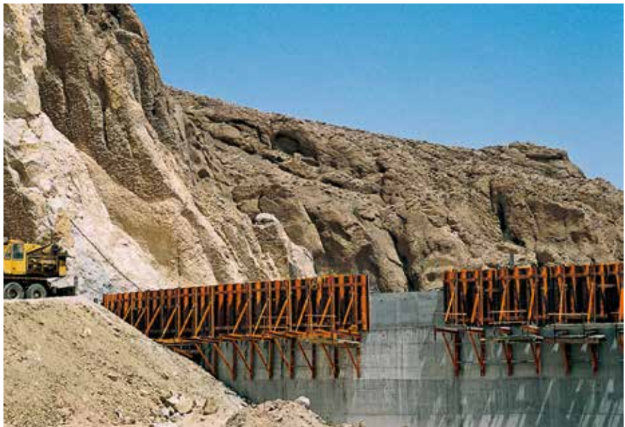
Staudamm „Barrage de Brezina“, DZ-Algerien; Fa. SEROR, Tlemcen DZ-Algerien
