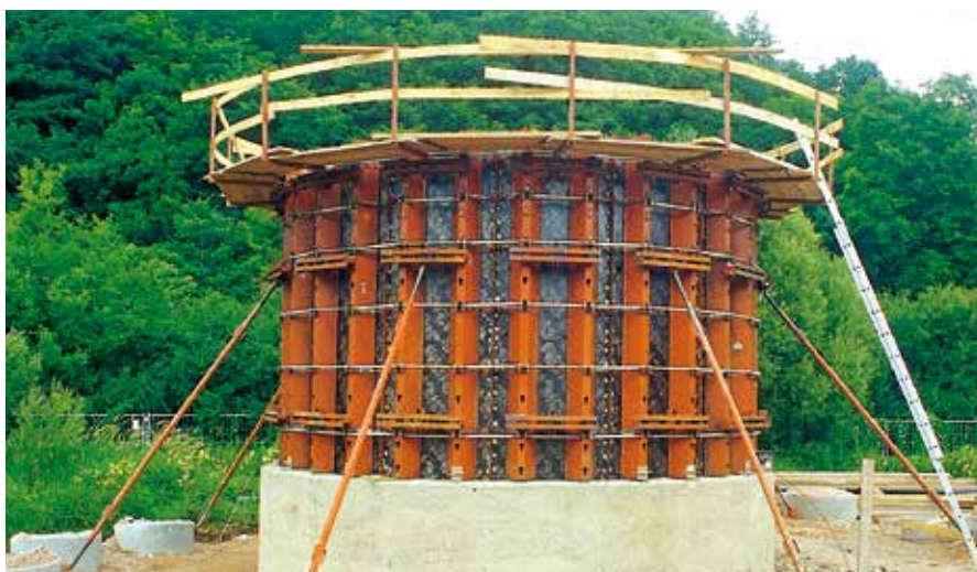
Sandfang Kläranlage, Wadern-Büschfeld; Ottweiler Baugesellschaft, Ottweiler
