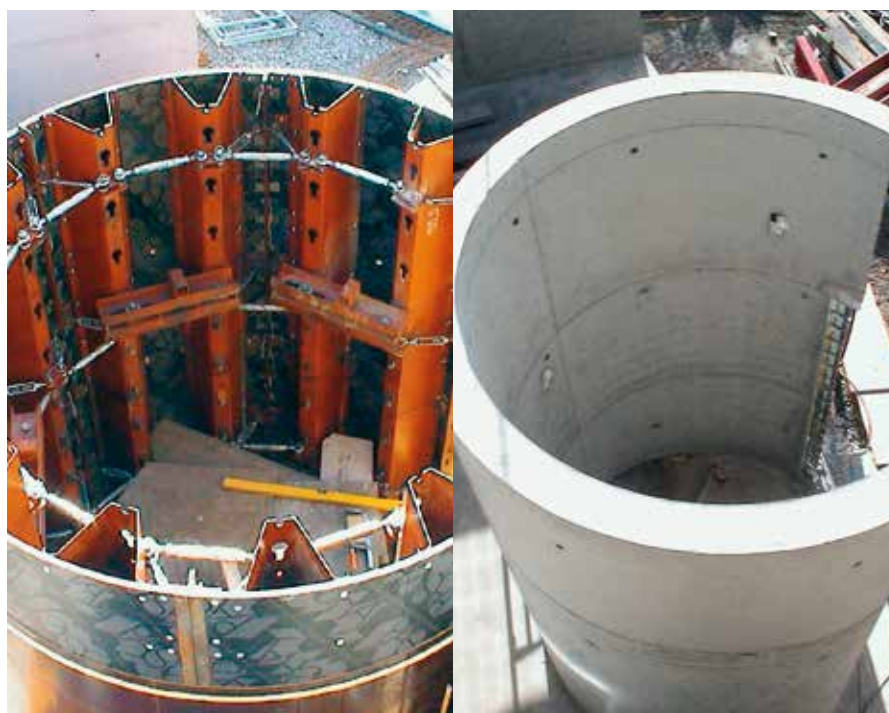
Wohn- und Geschäftshaus, Obrigheim; Fa. Jäckel, Oberwesel
