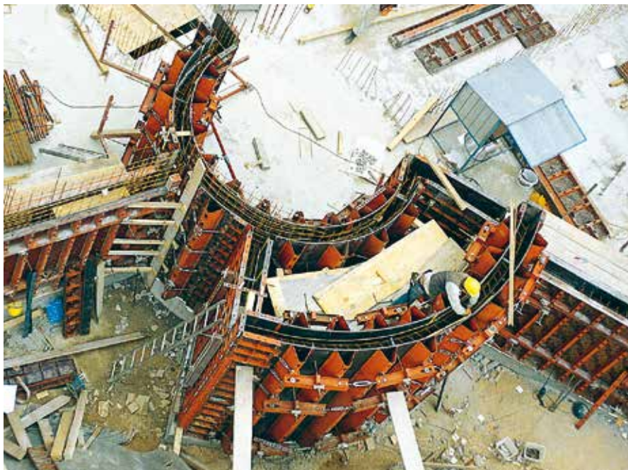
Wohnanlage, Berlin-Weißensee; Fa. Fritsche-Bau, Berlin
