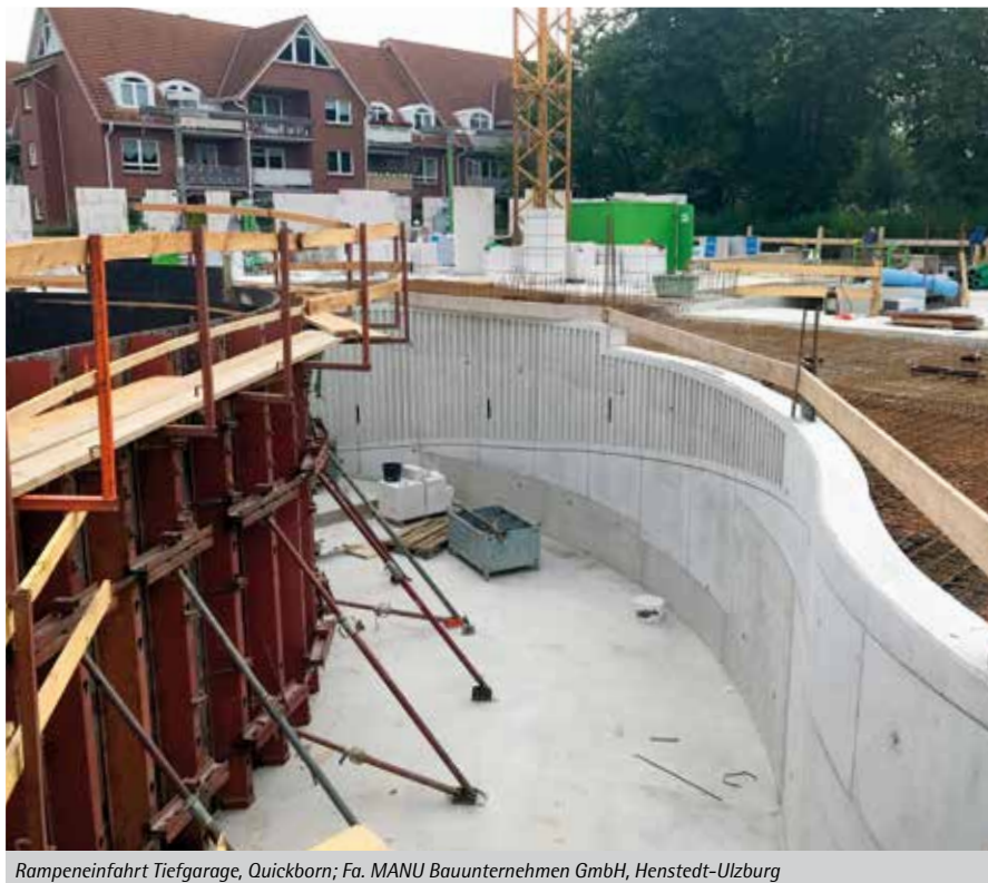
Rampeneinfahrt Tiefgarage, Quickborn; Fa. MANU Bauunternehmen GmbH, Henstedt-Ulzburg
