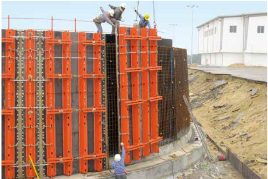
Kläranlage, KSA-Dammam; Fa. SysTech, KSA-Riyadh
