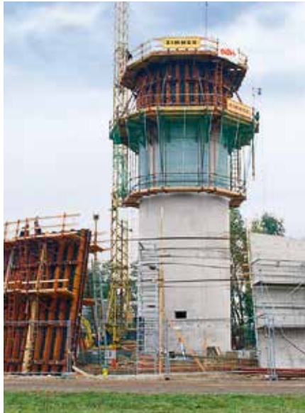
Kontrollturm, Flughafen F-Strasbourg; Fa. Zimmer SNG, F-Biesheim
