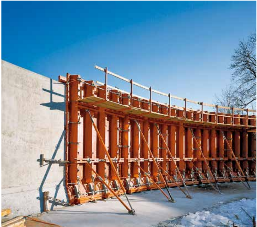
Kläranlage, Weilheim; Fa. Müller Hoch- und Tiefbau, Bad Urach
