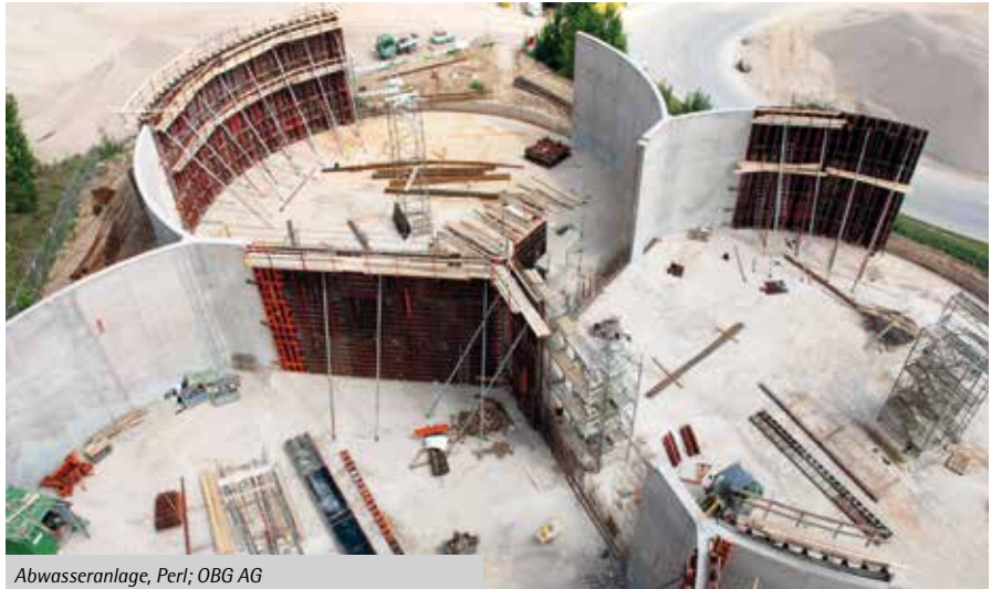
Abwasseranlage, Perl; OBG AG
