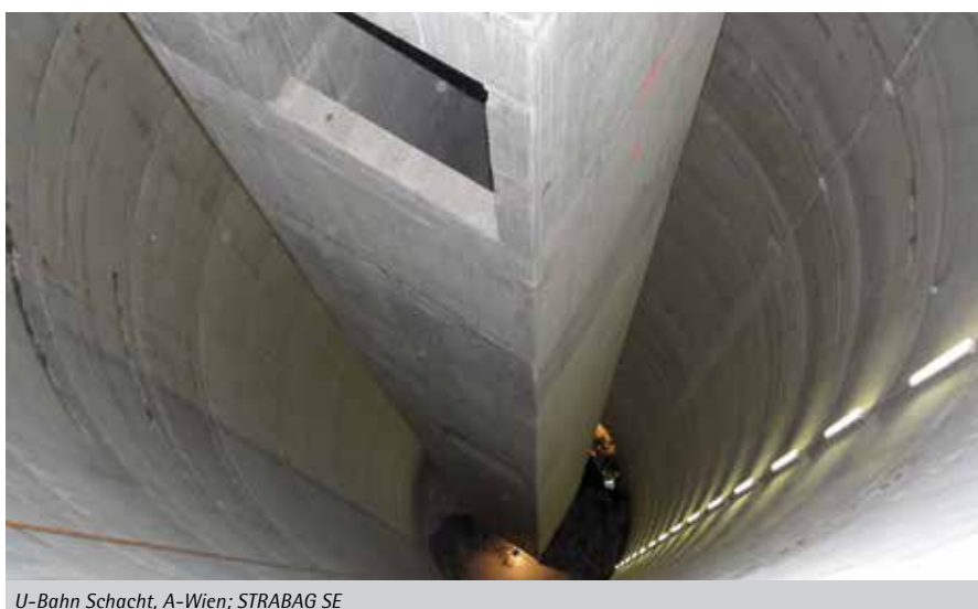
U-Bahn Schacht, A-Wien; STRABAG SE
