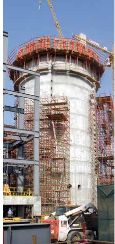
Erzverarbeitungsanlage, OM-Suhar ; Fa. Galfar Engineering & Contracting, OM
