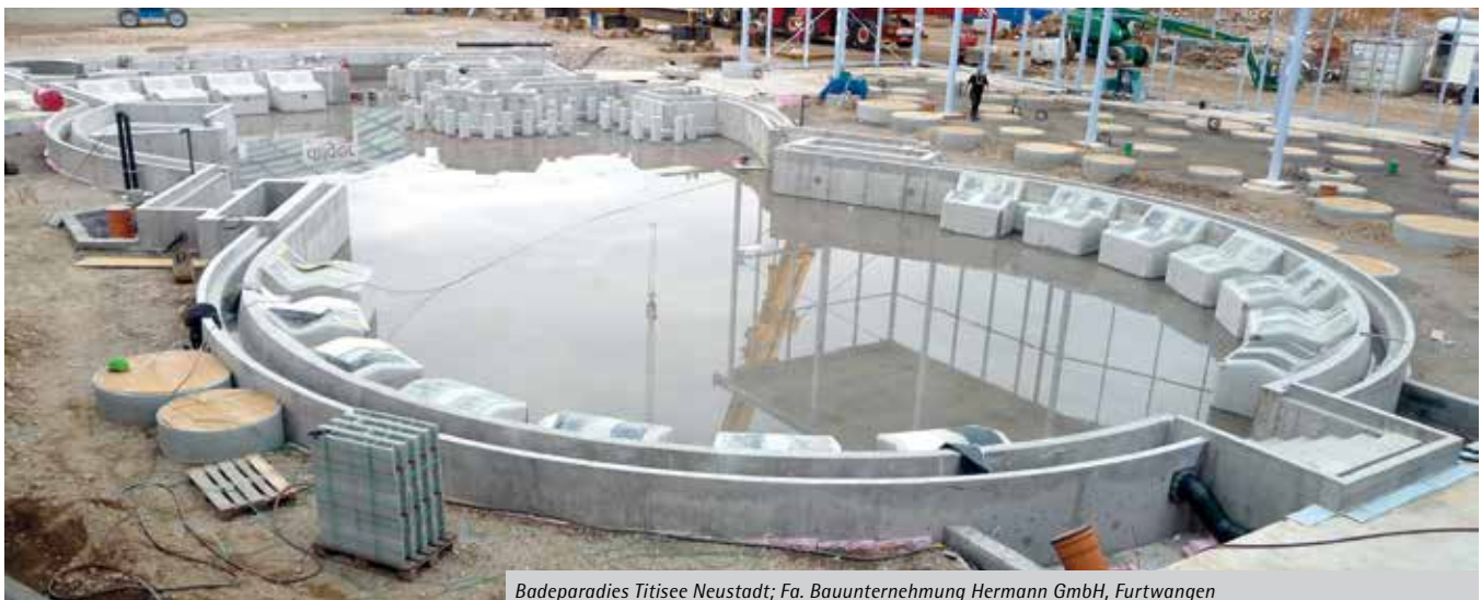
Badeparadies Titisee Neustadt; Fa. Bauunternehmung Hermann GmbH, Furtwangen
