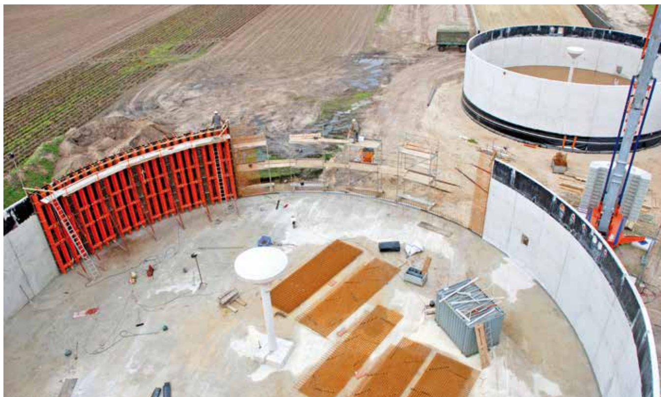
Biogasanlage, Laar; Fa. G. Büter Bauunternehmen GmbH & Co. KG, Ringe
