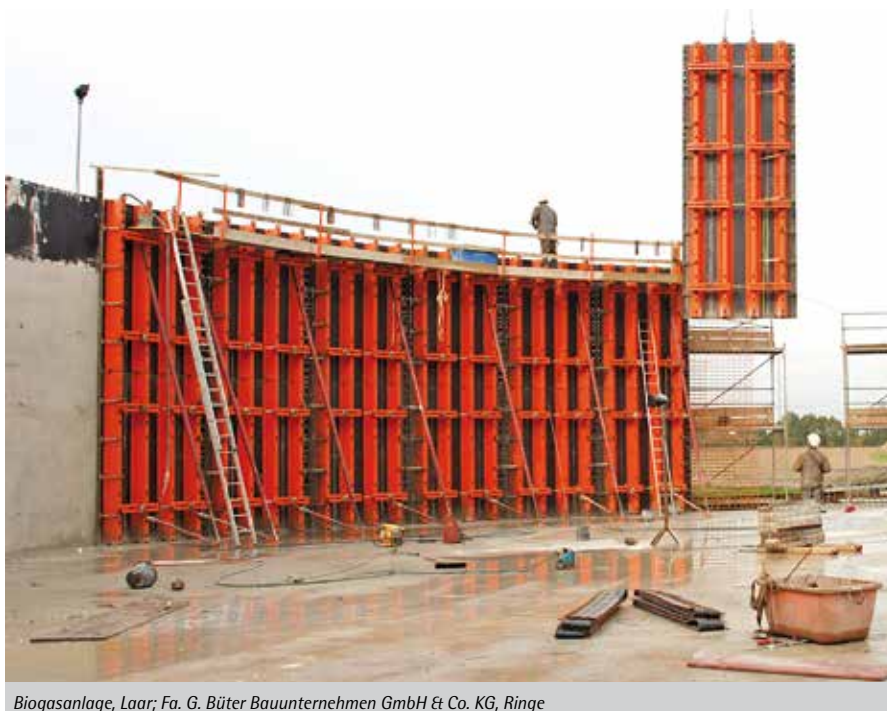
Biogasanlage, Laar; Fa. G. Büter Bauunternehmen GmbH & Co. KG, Ringe
