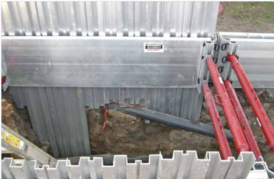
Mit dem Alu-Kammerplattenverbau GIGANT können kreuzende Leitungen leicht ausgespart werden. Der Verbau kann auch in rolligen, nicht standfesten Böden eingesetzt werden.
