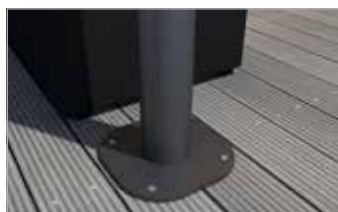
Vier Aluminiumsäulen auf Betonfundamenten sorgen für Stabilität
