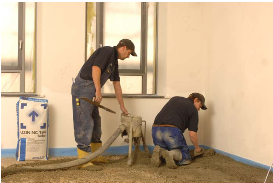
Bild 4: Einbau UZIN NC 194 Turbo mit Estrichpumpe
