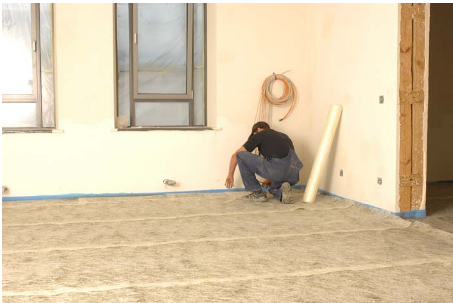
Bild 11: Armierte Fläche
