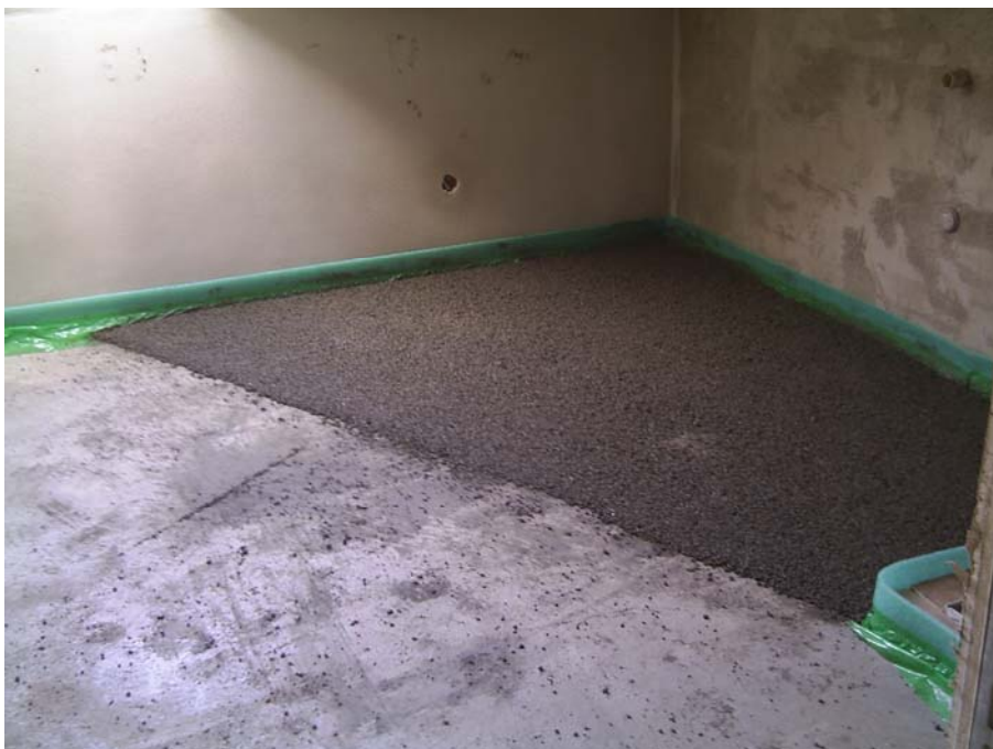
Bild 9: Baustelle Aussparung im Boden
