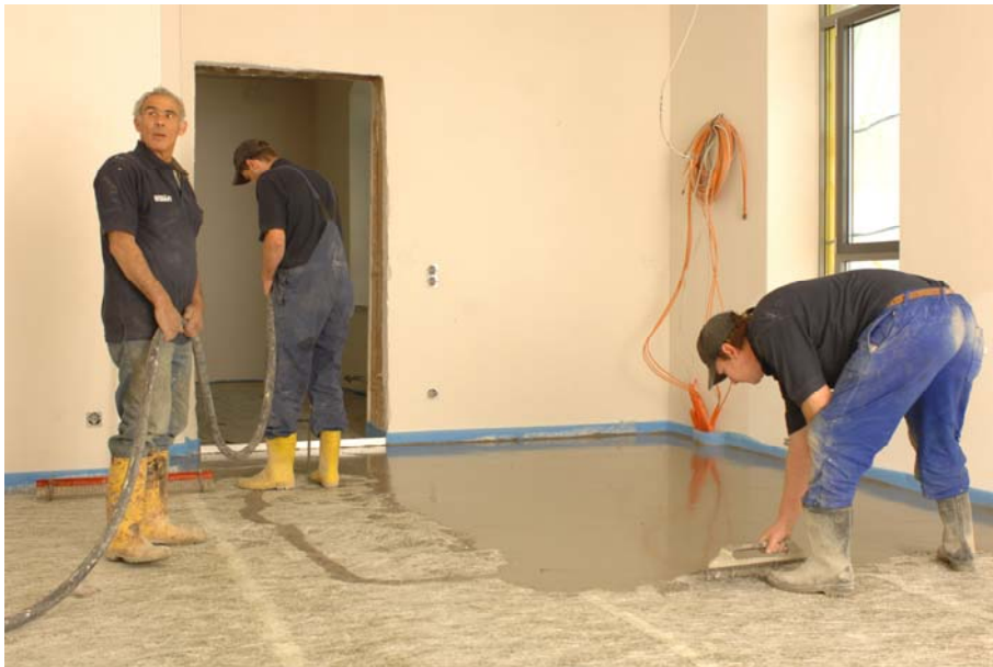
Bild 12: Pumpen von UZIN NC 195
