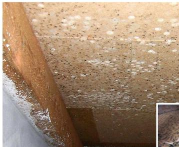
Schimmelpilzbefall durch ungenügende Abdichtung des Dachstuhls während der Bauphase - baubedingter Mangel
