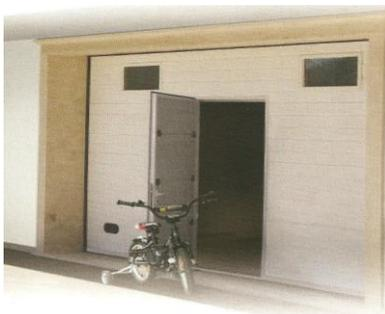
Portón acoplado en la misma puerta seccional.
