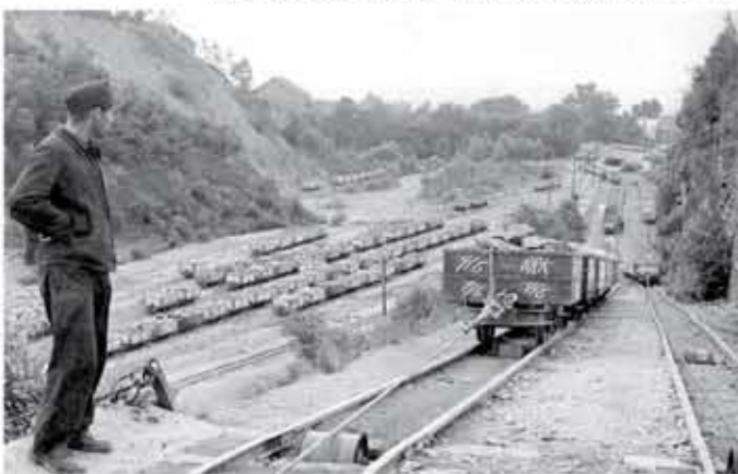
Bremsberganlage mit Kippwagen um 1954
