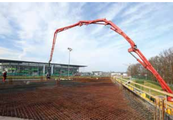
Betonpumpe gießt Fundamente des VfL-Centers
