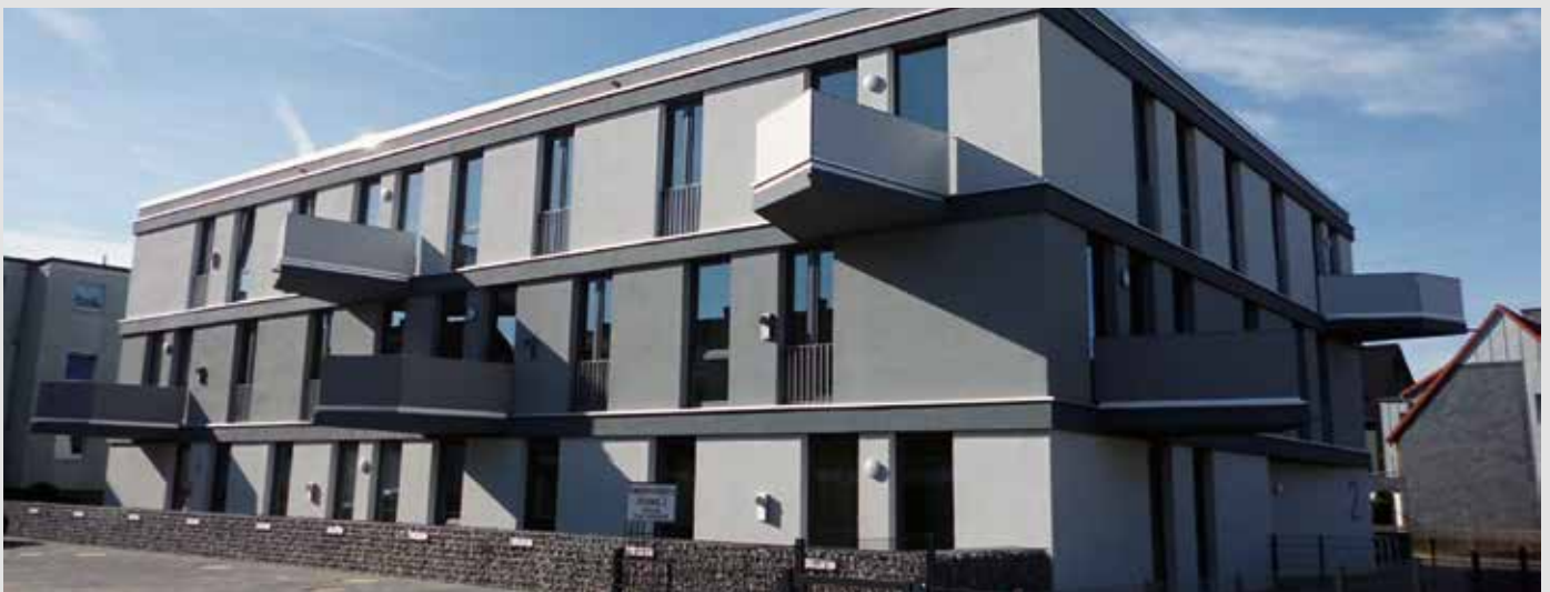
Hochwertige Architektur gepaart mit innovativer Technik – von der Eisspeicherheizung zur Luft-Wärmepumpe
