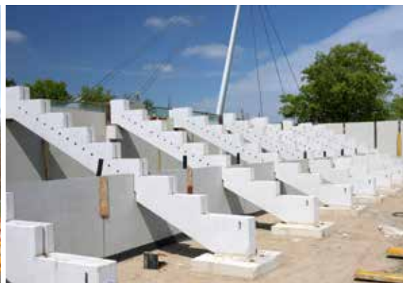
Zahnbalken als Unterbau für Sitztribünen im AOK Stadion
