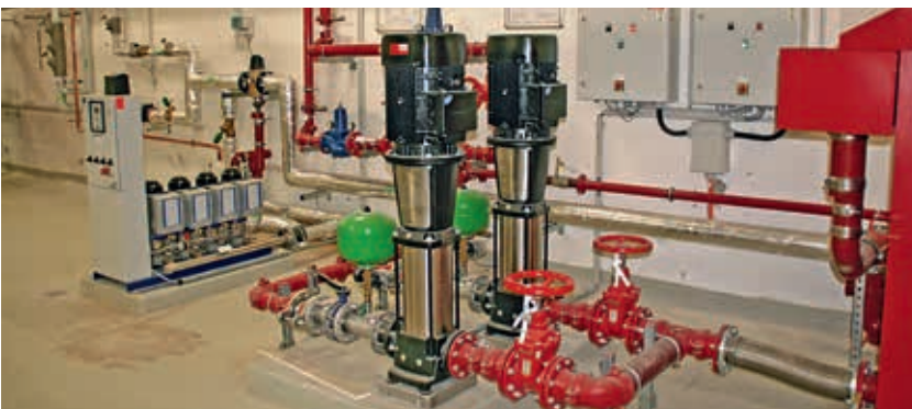
Qualitätsprüfung in der Energiezentrale mittels Datenerfassung / Monitoring
