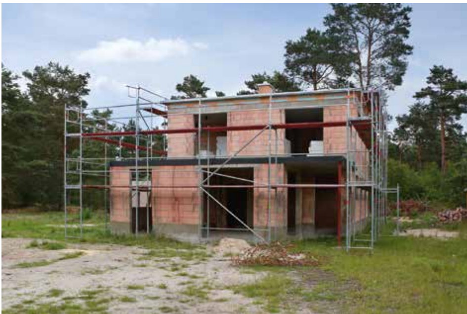
Am Bau gibt es eine Menge zu beachten - auch rechtlich.
