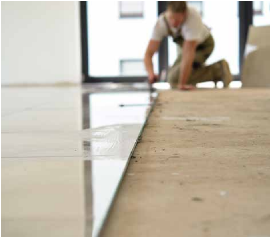
Wichtig: Umfassende Renovierungsarbeiten gelten als Herstellungskosten.
