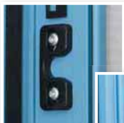
③ 1 butée et 1 ergot anti-soulèvement par panneau
