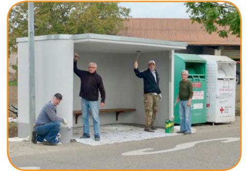
Bushaltehaus an der Assenheimer Straße grundrenoviert.
