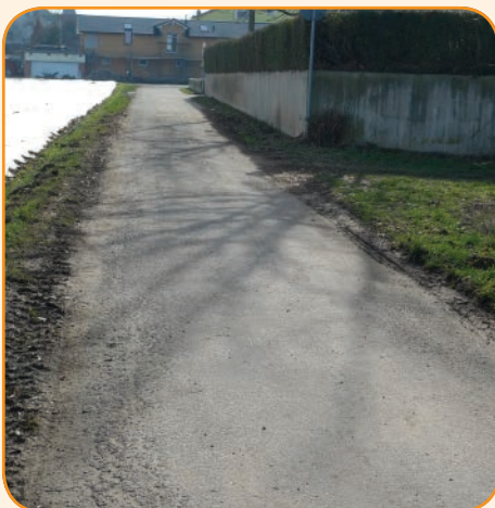
Einen Parkplatz am Friedhof im OT Rödersheim bauen.
