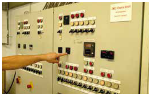
Die Schaltzentrale der Anlage
