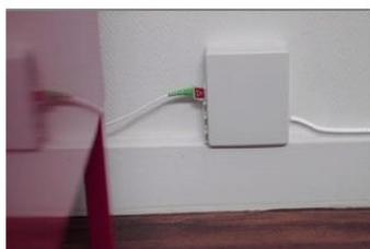
1. Le technicien va percer un trou au plus près de la porte d'entrée pour faire entrer le câble de la Fibre
