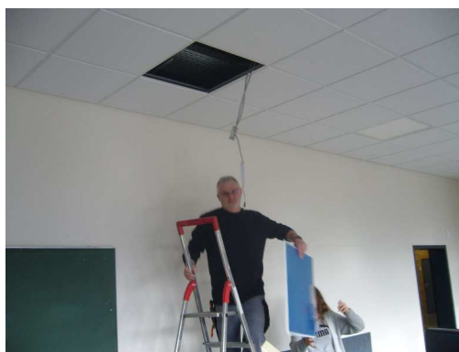
Abb. 15 – 19: Umrüstung eines Klassenraumes im Gebäudeteil
