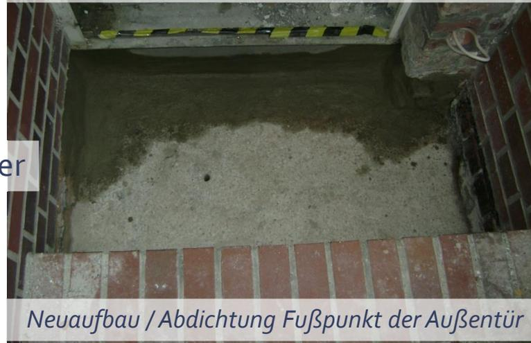
*Neuaufbau / Abdichtung Fußpunkt der Außentür*
