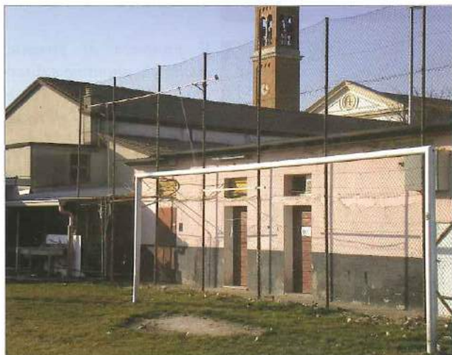
La parte retrostante verso mezzogiorno dei vecchi spogliatoi da calcio.
