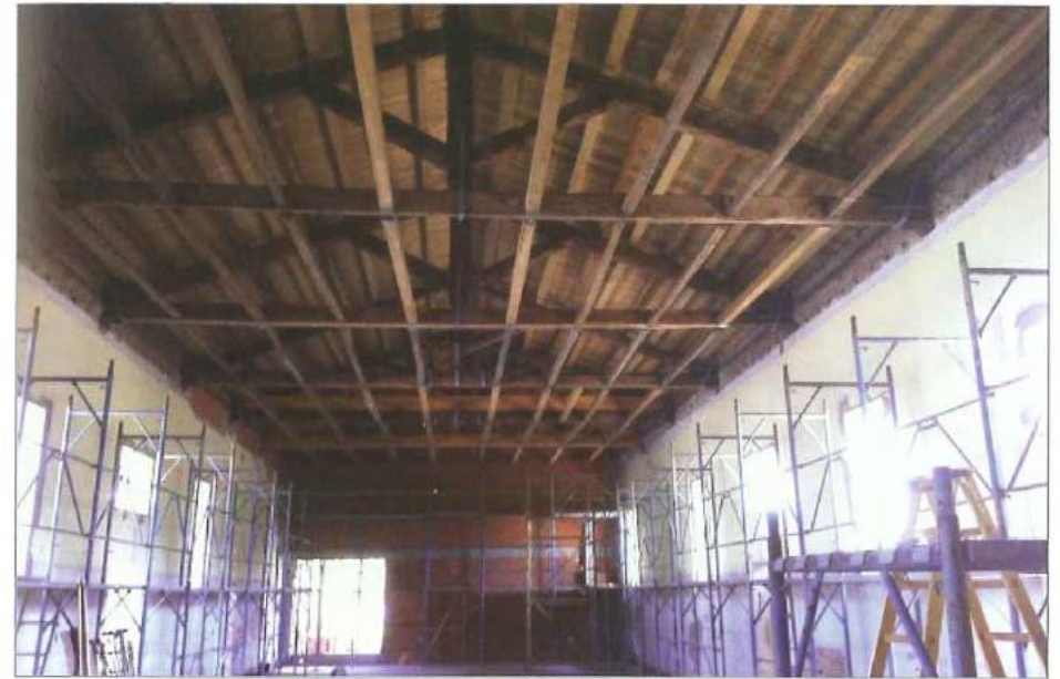
La struttura lignea del tetto del vecchio teatro una volta restaurata.
