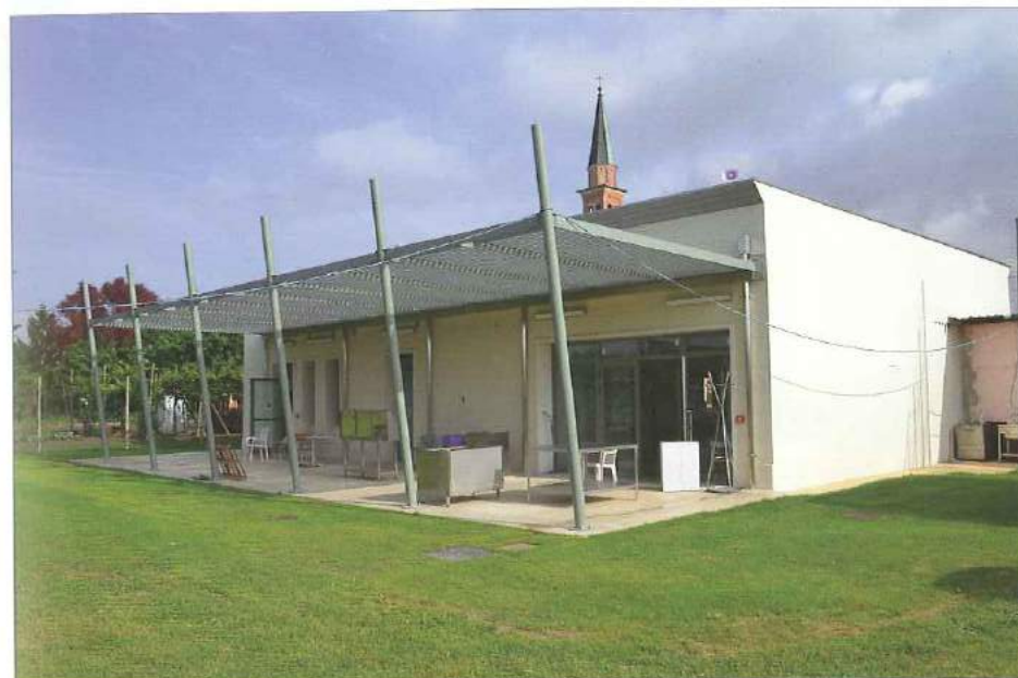
Il frangisole nella parte sud del nuovo edificio.
