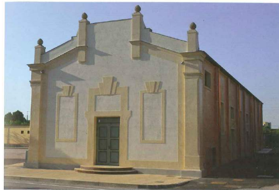
Ingresso della nuova sala Bellini ora dedicata a Melato/Saccardo. I colori della parete dell'edificio sono quelli originali risultanti dalle analisi stratigrafiche.
