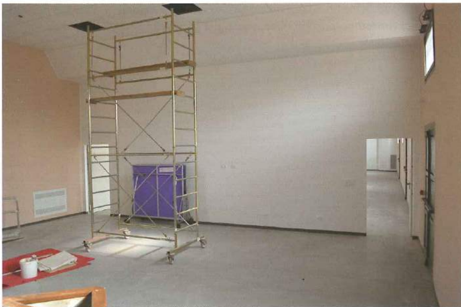
La sala piccola nella fase di montaggio delle lampade.
