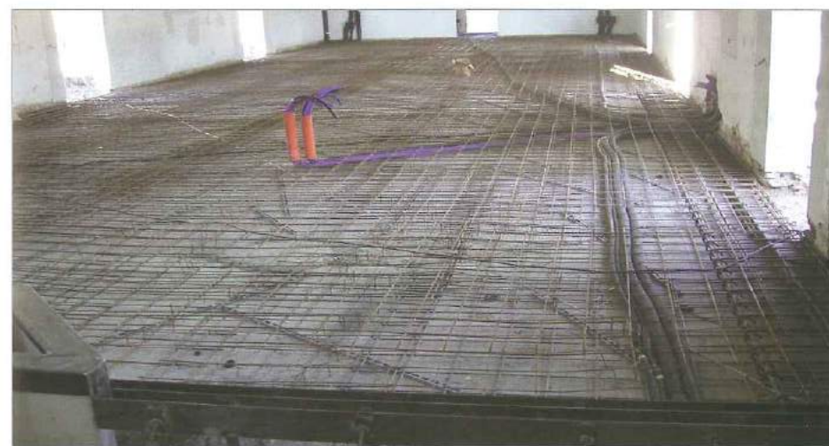
Realizzazione della platea di unione delle fondazioni
