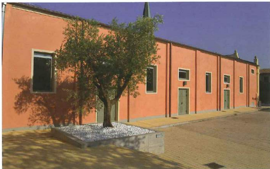
Il prospetto dell'edificio restaurato verso Piazza S. Salvatore. Il colore ripropone l'immagine di un tempo, quando la parete era senza intonaco a mattoni faccia-vista.
