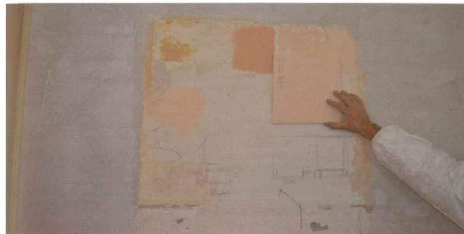
Recupero, attraverso l'esame stratigrafico, della pittura originaria interna della sala teatrale.
