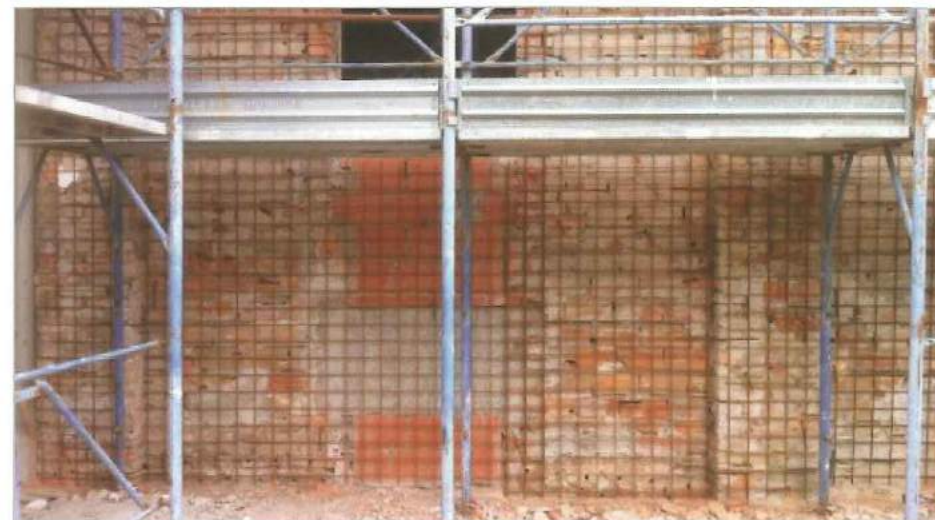
Rinforzo strutturale delle murature portanti perimetrali costruite nel 1943.
