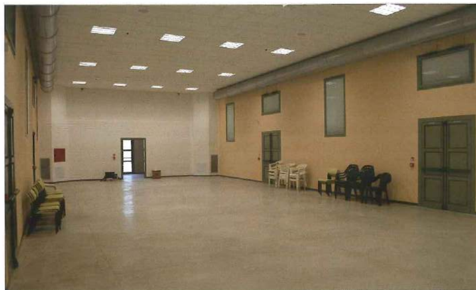
La sala a lavori conclusi.
