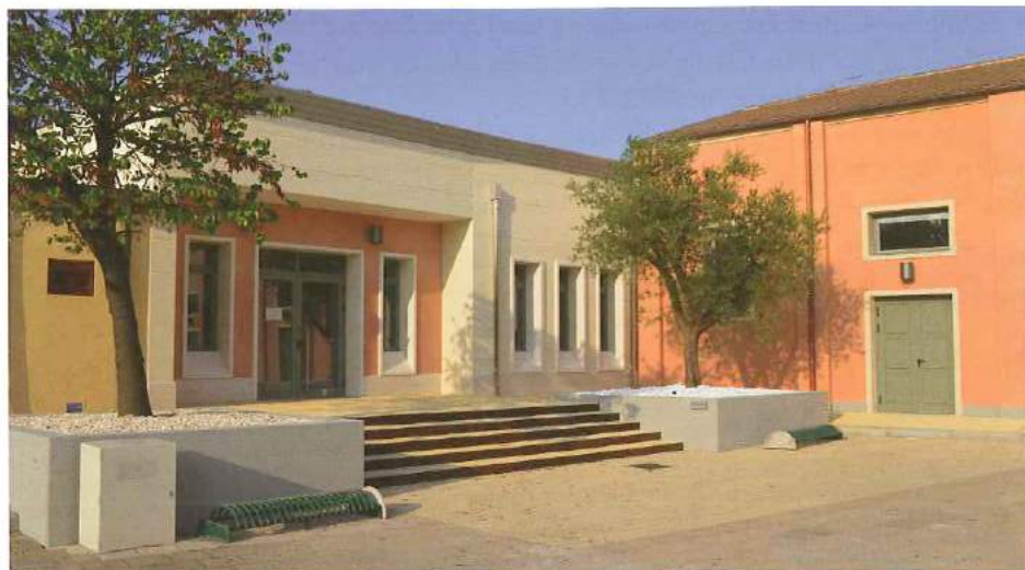
Ingresso principale del nuovo Centro Parrocchiale
