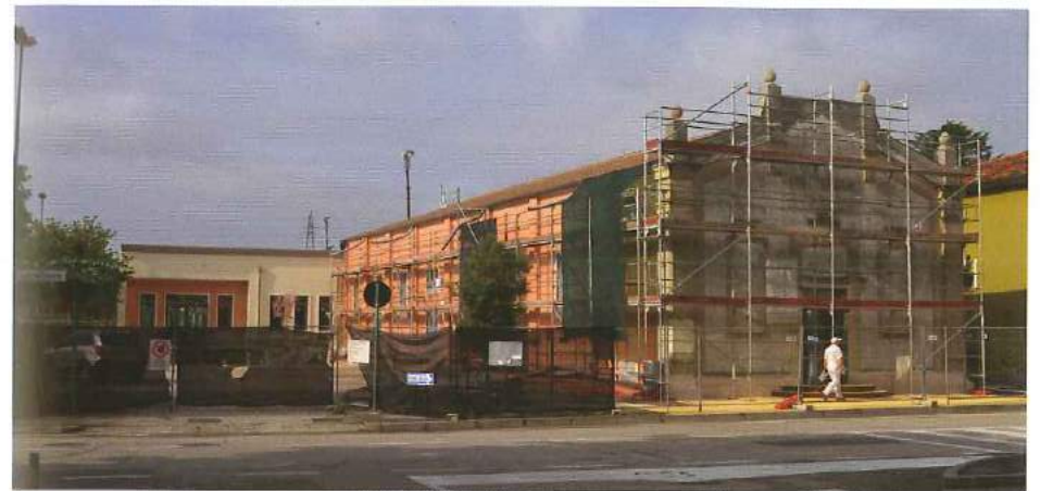
Durante i lavori di dipintura delle facciate esterne
