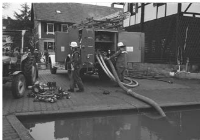
Löscharbeiten an der Scheune des Oberle-Hofes, 11. Januar 1994: Wasserentnahme aus dem Hofweiher mit Kosbacher LF16. (Stadtarchiv Erlangen, VIII.9607.N1-1_9, Foto: Stümpel)
