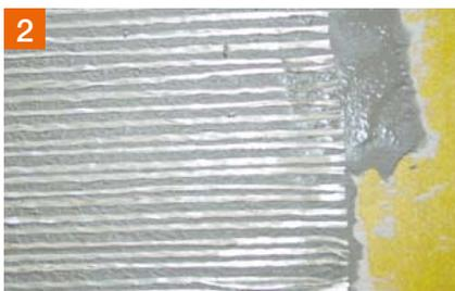
2 Eingelegte PCI Armiermatte GFS nach dem Abziehen der Trägerfolie.
