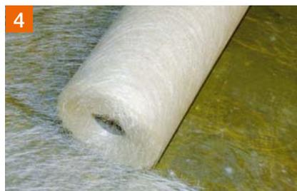
4 Auslegen bzw. Ausrollen der PCI Armiermatte GFM auf dem mit VG2 grundierten Untergrund.
