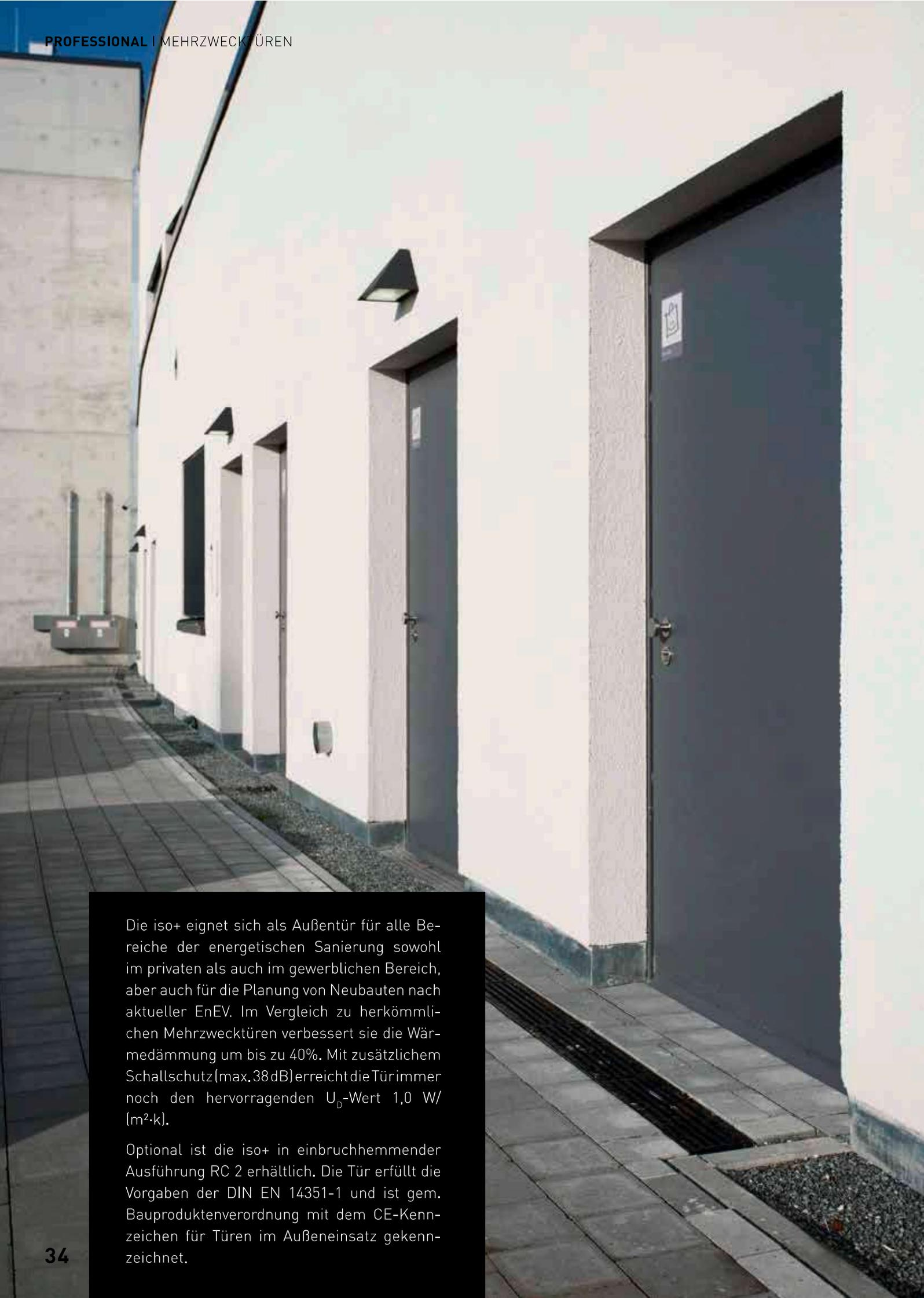
Die iso+ eignet sich als Außentür für alle Bereiche der energetischen Sanierung sowohl im privaten als auch im gewerblichen Bereich, aber auch für die Planung von Neubauten nach aktueller EnEV. Im Vergleich zu herkömmlichen Mehrzwecktüren verbessert sie die Wärmedämmung um bis zu 40%. Mit zusätzlichem Schallschutz (max. 38 dB) erreicht die Tür immer noch den hervorragenden  $U_D$ -Wert  $1,0 \text{ W} / (\text{m}^2 \cdot \text{K})$ .
