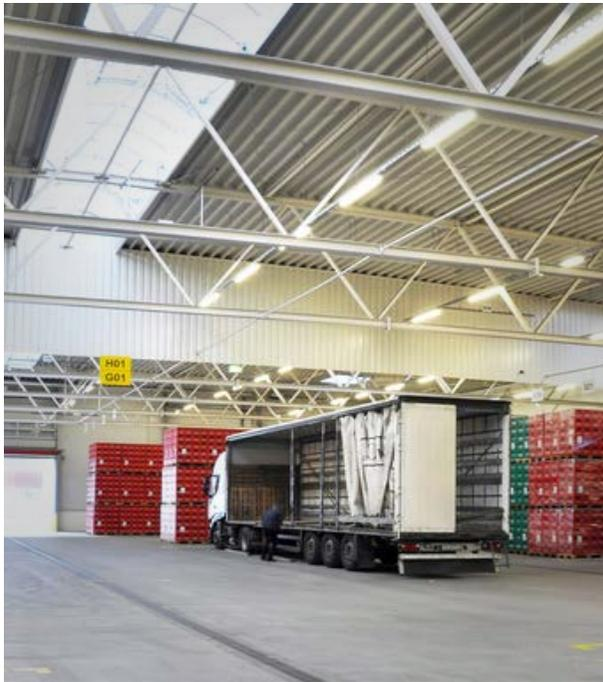
Praxistypische Ansicht einer Verladungshalle ohne Lichtsteuerung (Die Beleuchtungsanlage ist in Betrieb trotz ausreichendem Tageslicht).
