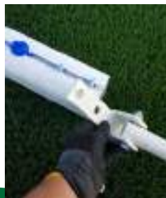
Colocación a base de poste.
