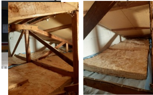
Bilder der verlegten Wärmedämmung
