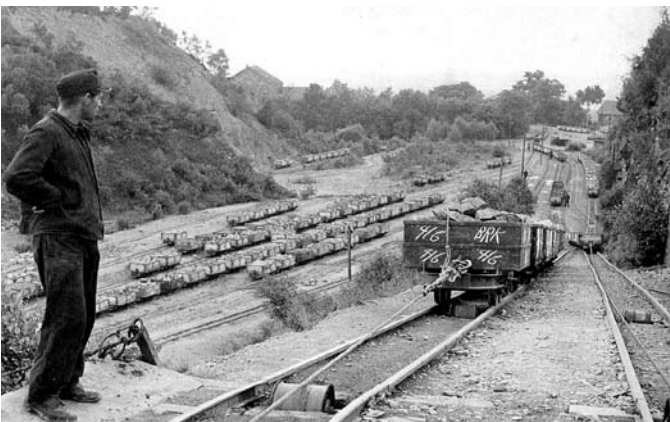
Bremsberganlage mit Kippwagen um 1954
