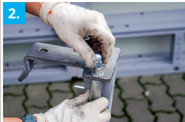
2. Dorn in Parkposition einsetzen
