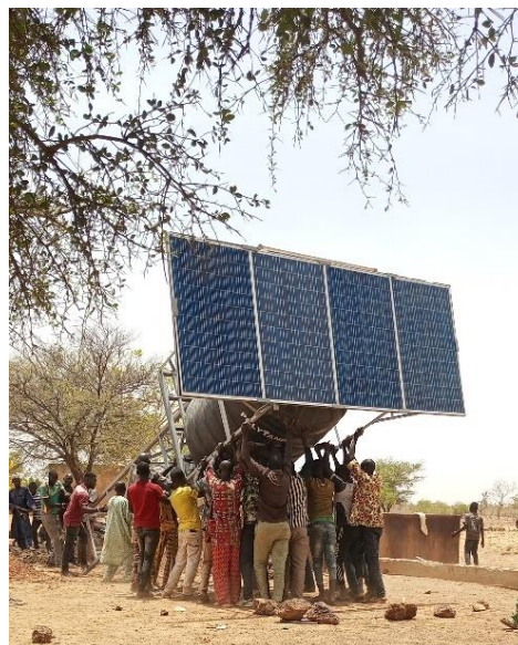
Der Wasserhochbehälter wird aufgerichtet
