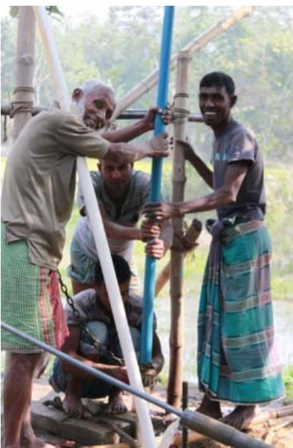
03 Bohren des Brunnens für die Wasserpumpe. Foto: MATI
