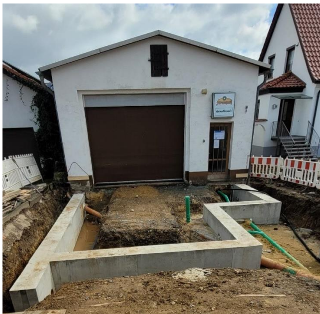
Baustelle am entstehenden Gemeindezentrum
