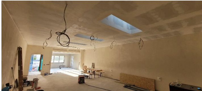
Die fertige Trockenbaudecke im Gemeindehaus.
