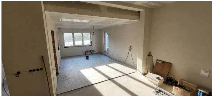
Der geflieste Küchenbereich.
