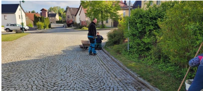
Martin Gundermann und Torsten Gruber bei der Reinigung der Straßeneinläufe.
