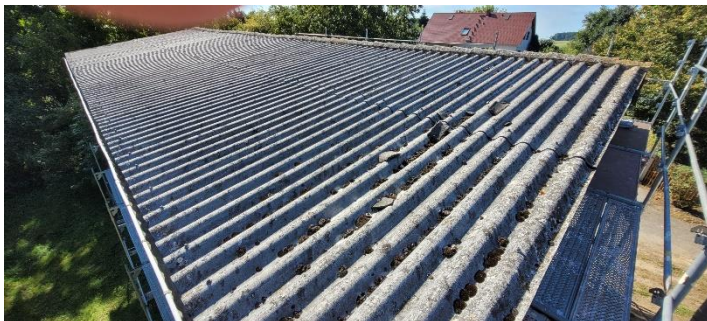
Vor der Erneuerung – Das alte Asbest-Dach
