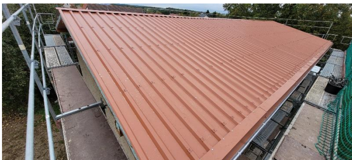
Die neue Eindeckung mit Trapezblech – Hier im Bild noch nicht ganz fertig
