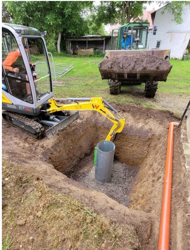
Tiefbauer beim Setzen des Mastunterteils
