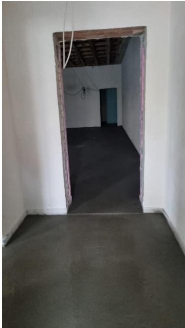
Der Estrich wurde eingebracht
