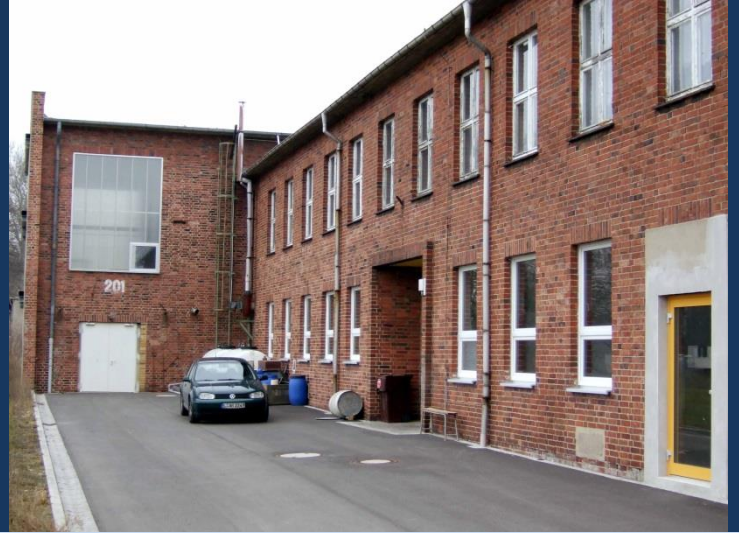
Abb. 3: EUT-Hauptgebäude mit Labor und Technikum
