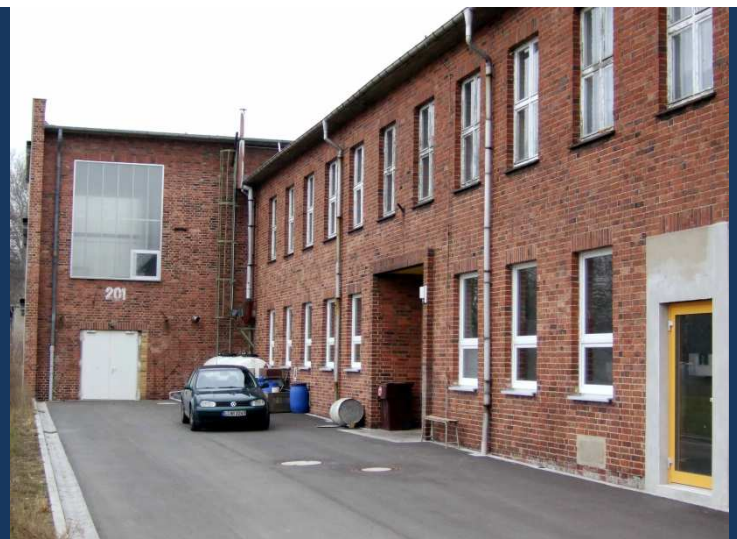
Abb. 3: EUT-Hauptgebäude mit Labor und Technikum
