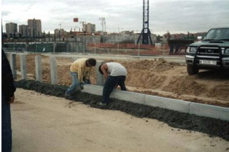
Colocación de bordillos
