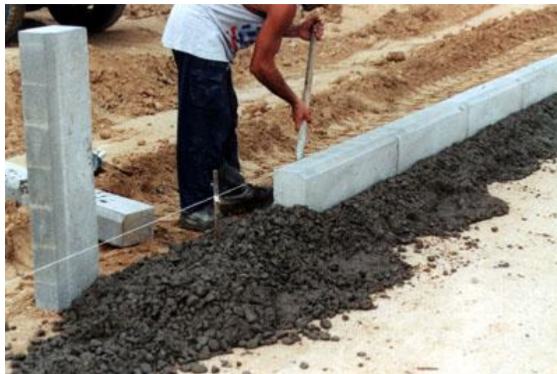
Ejecución del trasclusado con mortero de cemento
