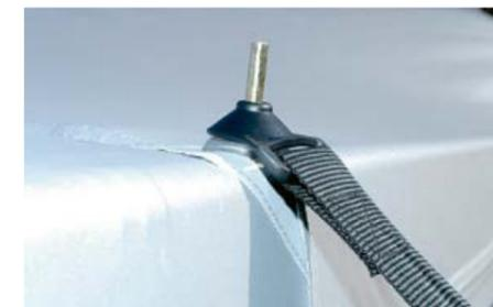
▲ Die Sturmgurte werden mit Kunststoffadaptern am Gestängedorn befestigt.
