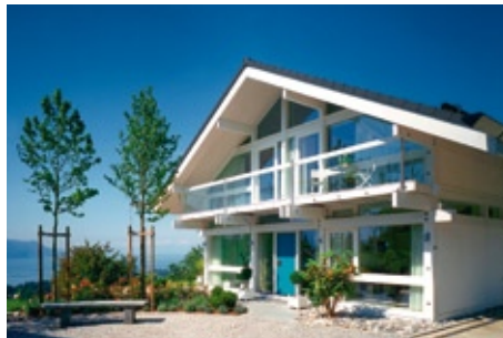
KNX für vernetzte Systemhäuser
