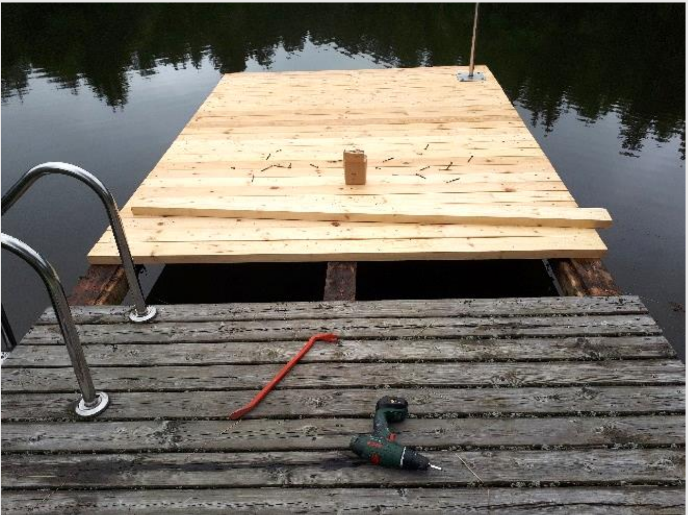
Da einige Holzbohlen auf dem Steg bei den Umkleidekabinen nicht mehr in Ordnung waren, wurde der ganze Liegebereich auf dem Steg erneuert.
