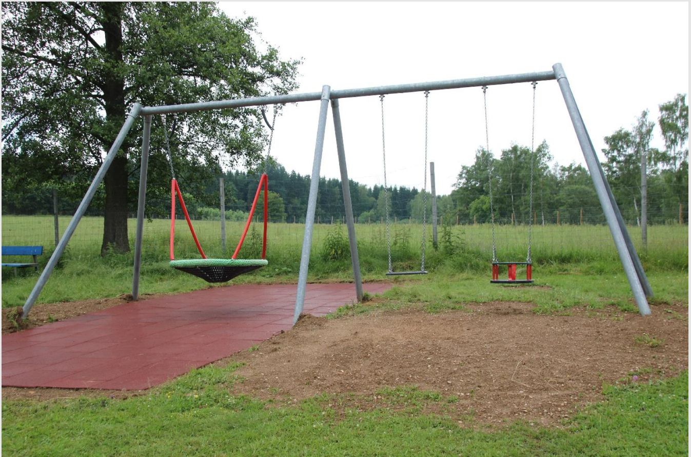
Die versetzte Schaukelanlage mit dem neuen Fallschutz für die Vogelnestschaukel.
