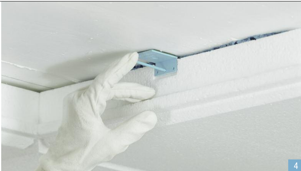
Dämmplatte ausrichten und Fixierungsnagel einstecken.
